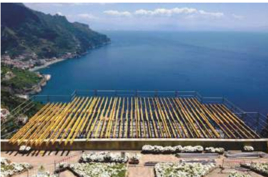
Фото 13. Будівництво сцени «Бельведере»
